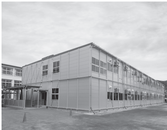
施工事例 (仮設庁舎)
