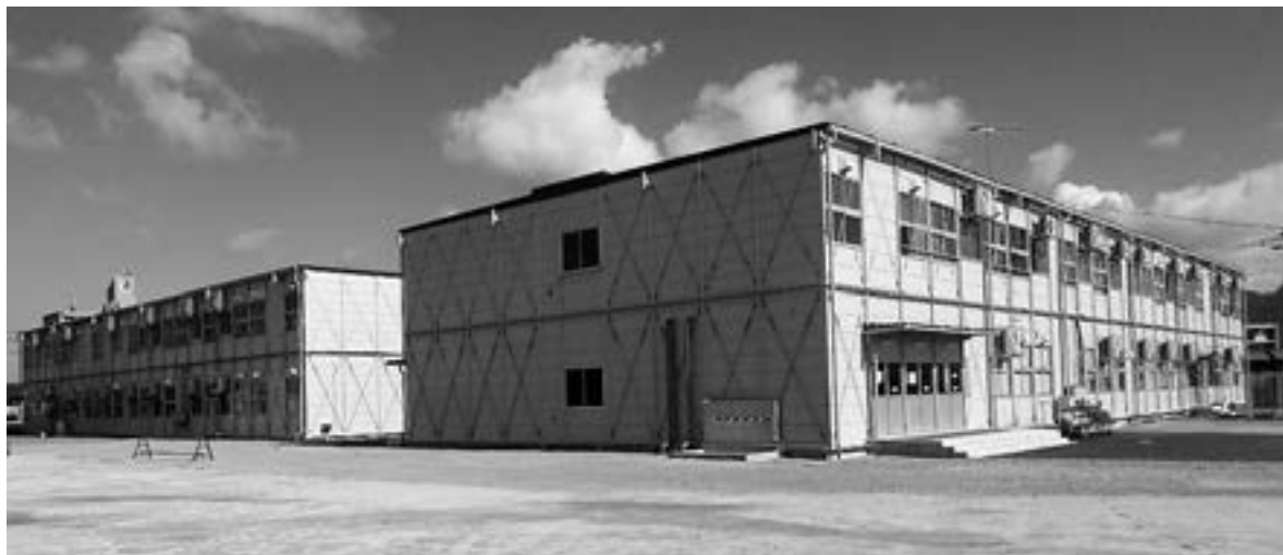
施工事例 (仮設校舎)
