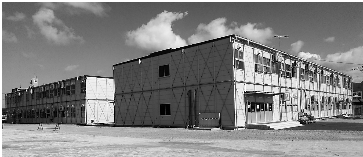
施工事例 (仮設校舎)
