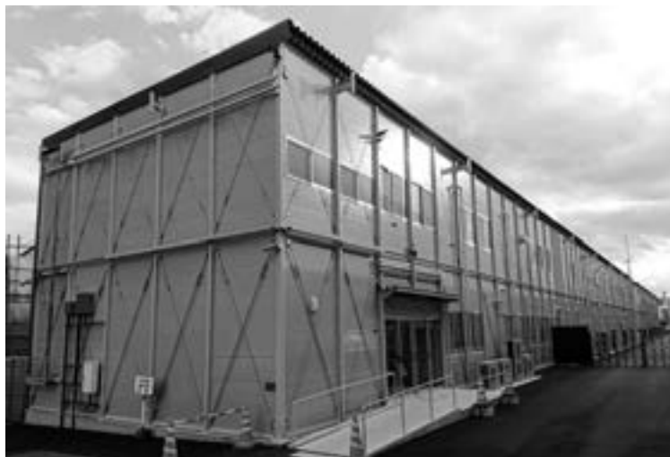
施工事例 (仮設庁舎)
