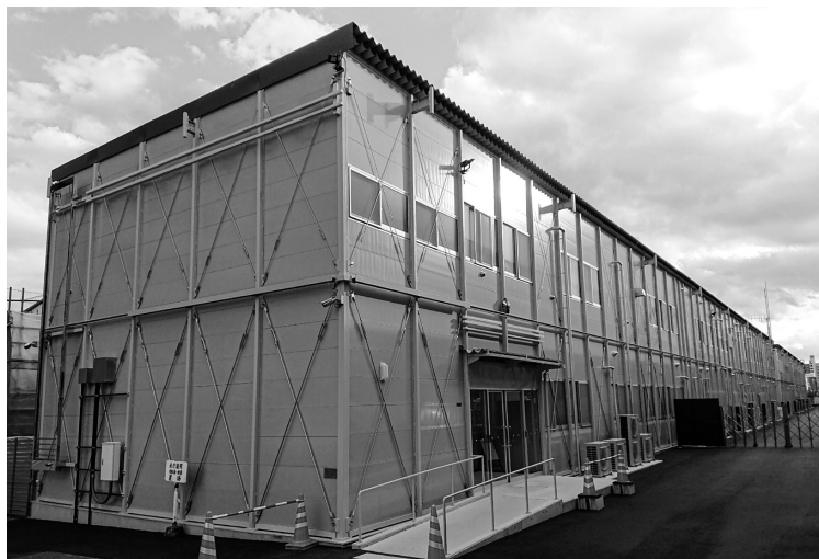
施工事例 (仮設庁舎)
