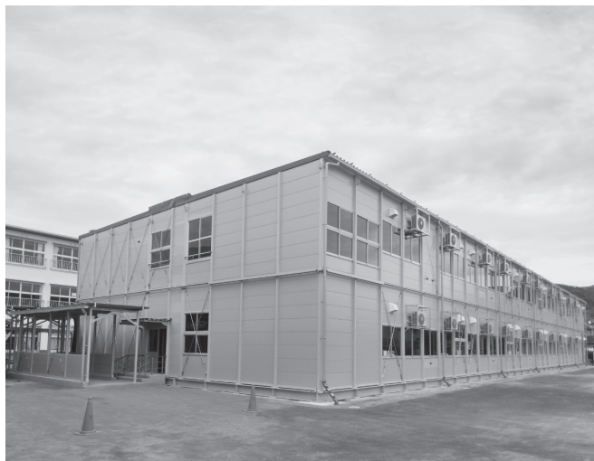
施工事例 (仮設庁舎)
